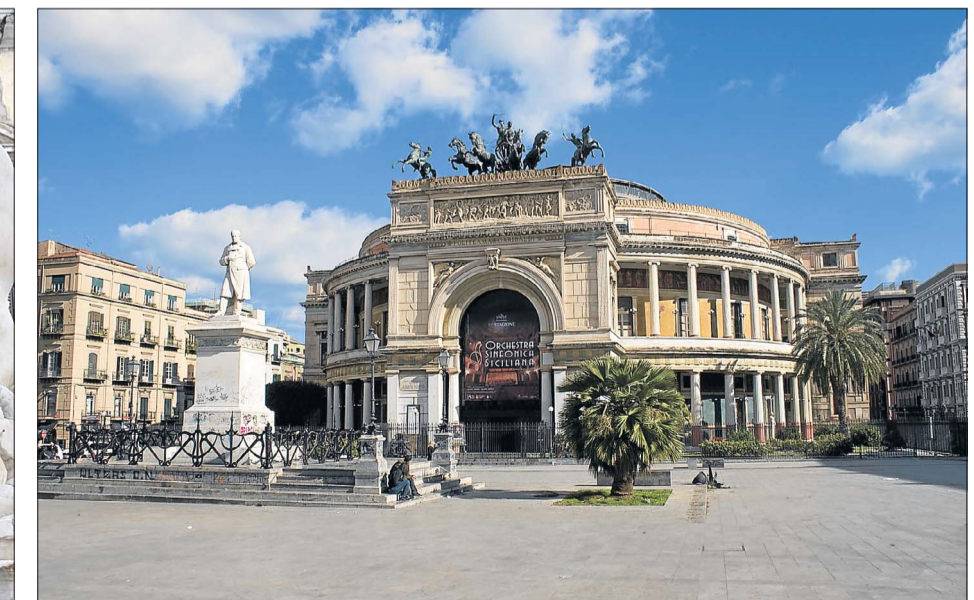
Wundervolles Bauwerk: Zwischen 1867 und 1874 erbaute man das Teatro Politeama. Es wurde im neoklassizistischen Stil gehalten.
